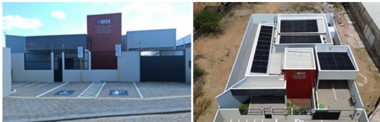
Figuras 27a e 27b - Construção da nova sede da Pmj de Florânia
